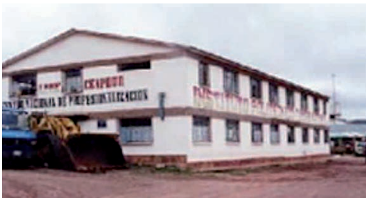
Construcción del edificio del CENPRUR - Ocurí, 1979 Foto: Archivo IPTK
