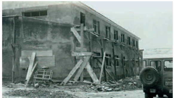
Construcción del Edificio del CENPRUR - Ocurí Foto: Gentileza Franz Huls
